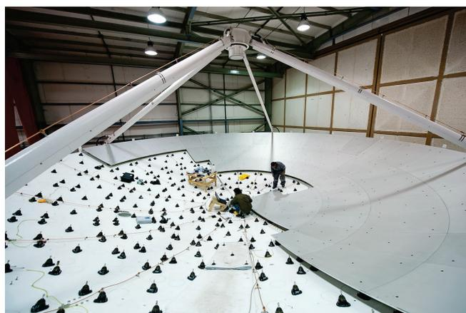
Imagen 6: Construcción de una de las antenas ALMA; una antena construida a partir de fibra de carbono (compuesta de 24 sectores) es recubierta con paneles metálicos (264 partes). La desviación de un paraboloide ideal puede ser de un máximo de 25 micrómetros. Aparentemente la superficie es mate y no brilla. Ésto se debe a una rugosidad deseada en comparación con la luz visible (Fuente: ESO/José Francisco Salgado, josefrancisco.org).
