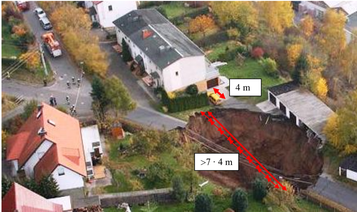
Einsturzkrater eines Erdfalls, der sich am 1. November 2010 in der südthüringischen Kleinstadt Schmalkalden ereignete (Quelle: Thorsten Poszwa, Volvo Construction Equipment Germany GmbH).
