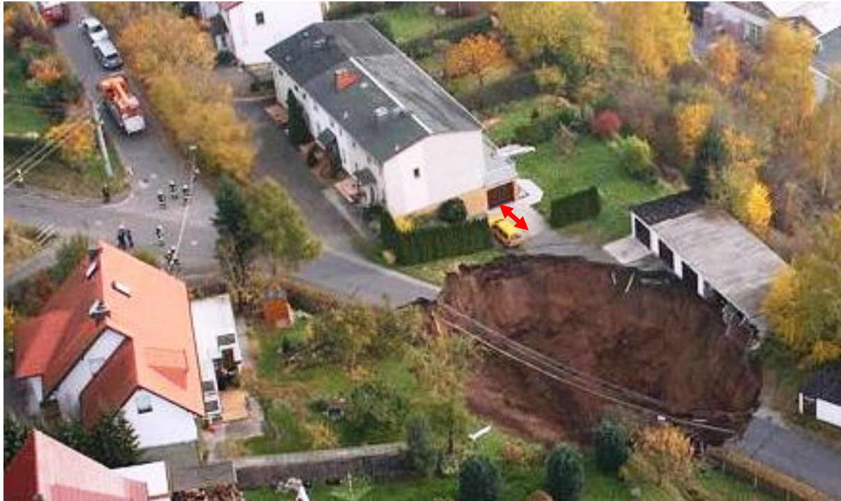
Einsturzkrater eines Erdfalls, der sich am 1. November 2010 in der südthüringischen Stadt Schmalkalden ereignete (Quelle: Thorsten Poszwa, Volvo Construction Equipment Germany GmbH).
