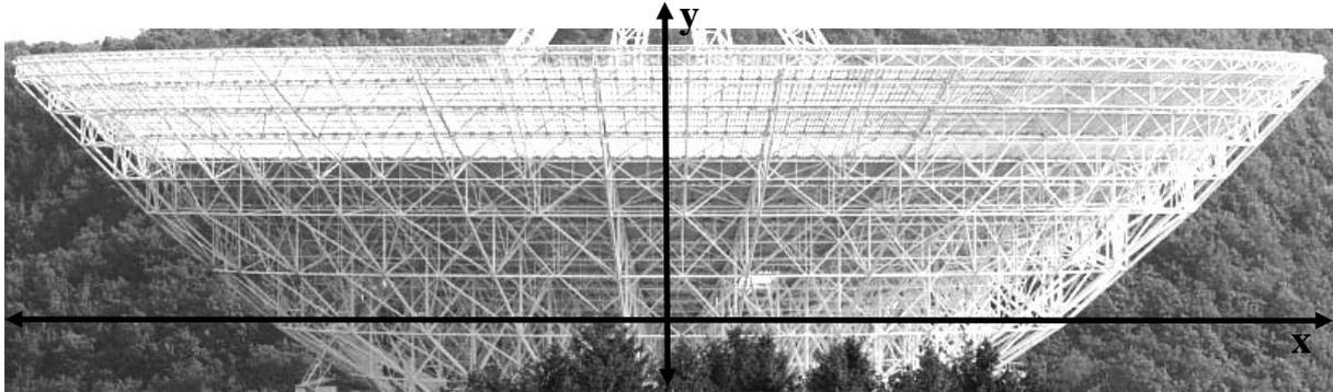
Das Bild zeigt eine Seitenansicht der parabolisch geformten Reflektorschüssel (eine Art Hohlspiegel) des Radioteleskops Effelsberg (bei Bonn). Sie ist eingehüllt durch eine, die homologe Verformung garantierende Tragekonstruktion. Bei genauem Hinsehen kannst Du die parabelförmige Reflektorschüssel durch das Tragegerüst hindurch erkennen.
