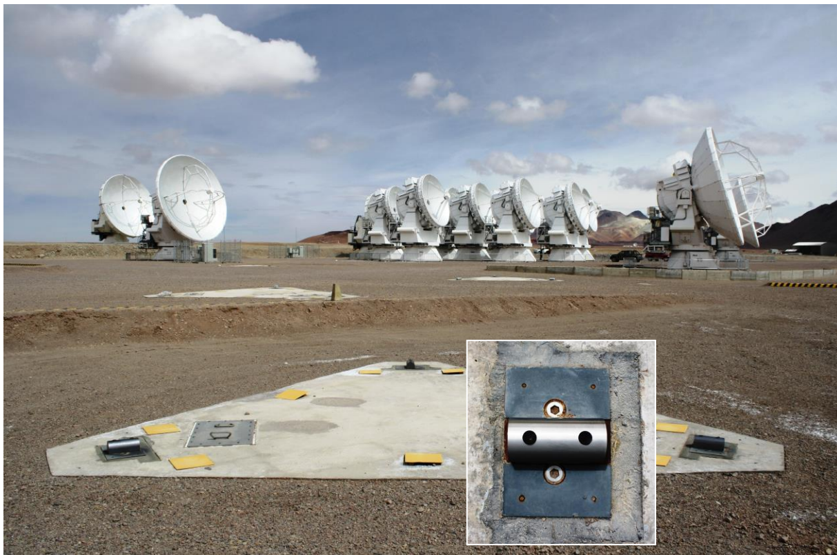
Abbildung 28: Im Vordergrund ist eines von 192 installierten Fundamenten für die möglichen Aufstellorte von ALMA-Teleskopen zu sehen. Im Hintergrund zu sehen sind Teleskope des Teilarrays ACA (Atacama Compact Array), welches aus 12 7-m-Schüsseln und 4 12-m-Schüsseln besteht. ©: Olaf Fischer.
